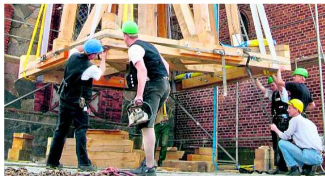
Die schwebende Holzkonstruktion kurz vor dem „Abflug“.
